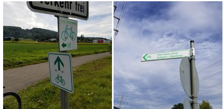
Demontage Rad ZWW: 1 Pfeil: 1 Beanstandung: nicht FGSV-konform
