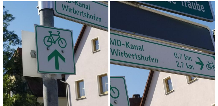
Demontage Rad ZWW: 2 Pfeil: 1 Beanstandung: nicht FGSV-konform
